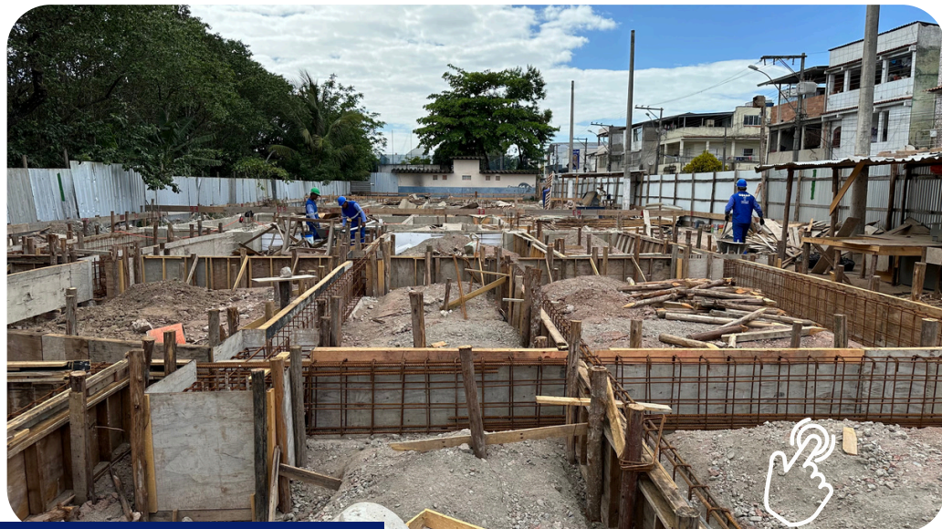
Preparando o fundamento
