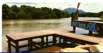
Deck e rampa no ponto final
